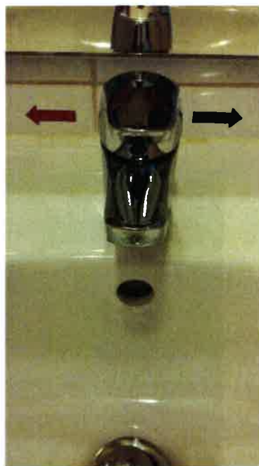
Mitigeur avec repaire chaud – froid sur les lavabos et évier
