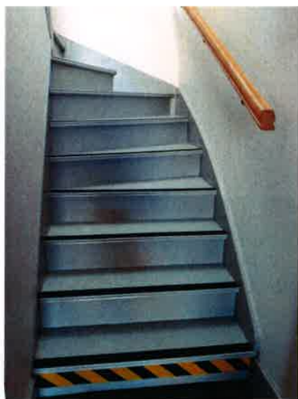
Repaire sur les marches et contraste des rampes
