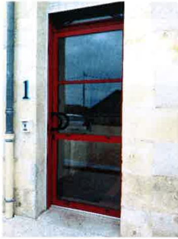
Porte d'entrée avec élément de repérage à deux hauteurs différentes et identification des bâtiments par un numéro
