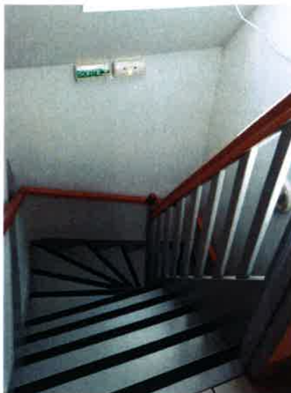
Repaire sur les marches et contraste des rampes
