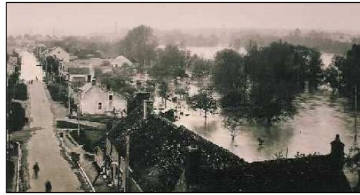
Crues à Saint Florent sur Cher
